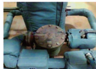
写真3 蒸気配管の外観
