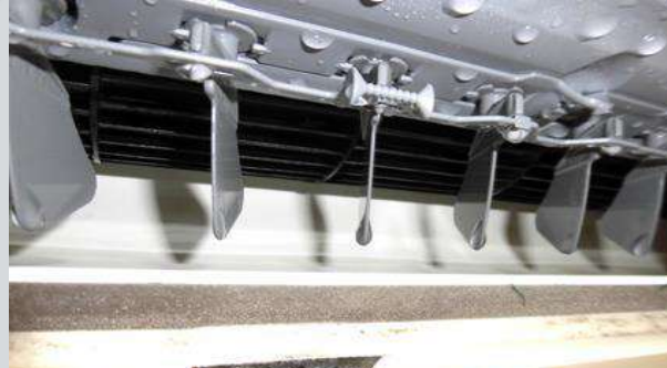
守護神を添加した洗浄水を吹き付け洗浄
