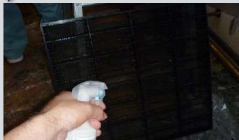
洗浄したドレンパン・フィルターに カビ守護神を噴霧しスライム・ぬめり防止
