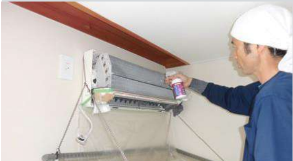
カビ守護神を吹き付け防カビ処理
