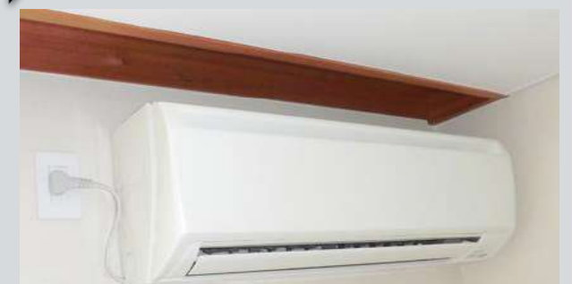
フィルター・パネル ルーバーを取付け
