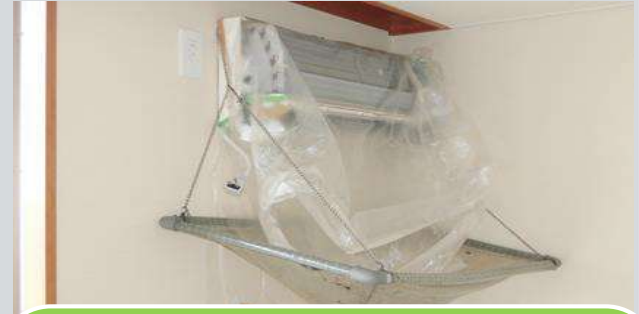
エアコン本体洗浄のため養生
