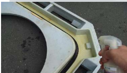
洗浄したドレンパン・フィルターに カビ守護神を噴霧しスライム・ぬめり防止
