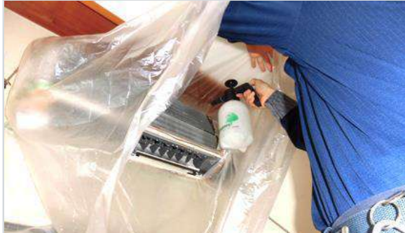
守護神を添加した洗浄水を吹き付け洗浄
