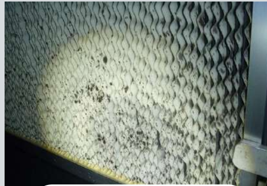
交換前フィルター カビ発生状況
