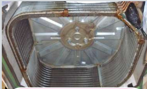
分解完了状況
