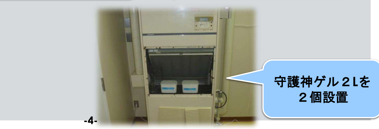
フィルター類 カビ守護神にて防カビ処理
