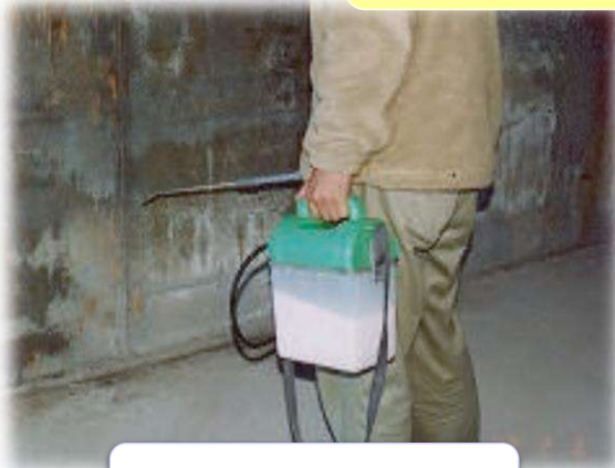
コンクリート壁
