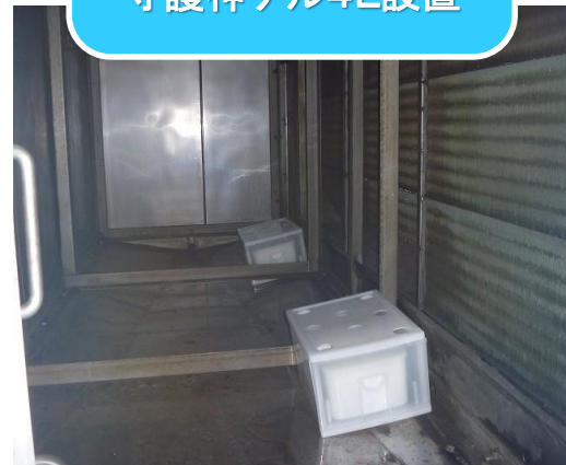
守護神ゲル4L設置
