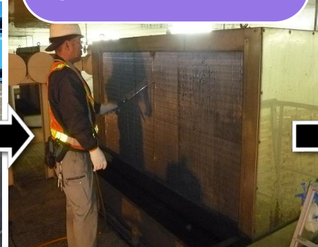
③熱交換器高圧洗浄
