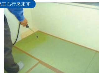
畳への防カビ施工
