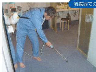
脱衣所の床面を除菌後、防カビ
