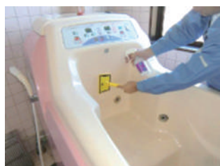
浴槽に防カビコート
