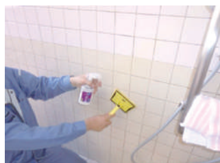
浴室タイルに防カビコート
