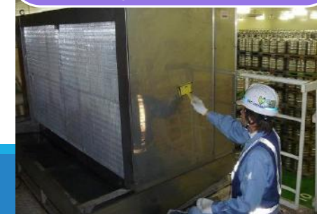
⑥カビ守護神コーティング剤 防カビ処理
