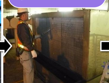
③熱交換器高圧洗浄
