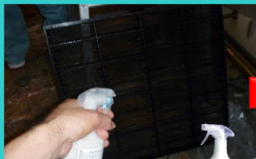
洗浄したドレンパン・フィルターにカビ守護神を噴霧し、 スライム・ぬめり防止に
