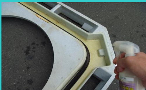
洗浄したドレンパン・フィルターにカビ守護神を噴霧し、 スライム・ぬめり防止に
