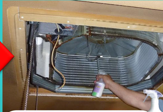
熱交換器にカビ守護神 吹き付け
