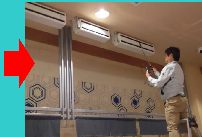
風量の測定をし、異常がないかを確認します。
