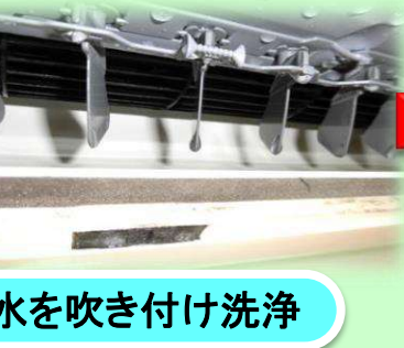
熱交換器やフィルターにホコリが堆積
