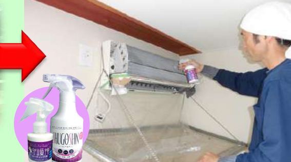
カビ守護神を吹き付け防カビ処理
