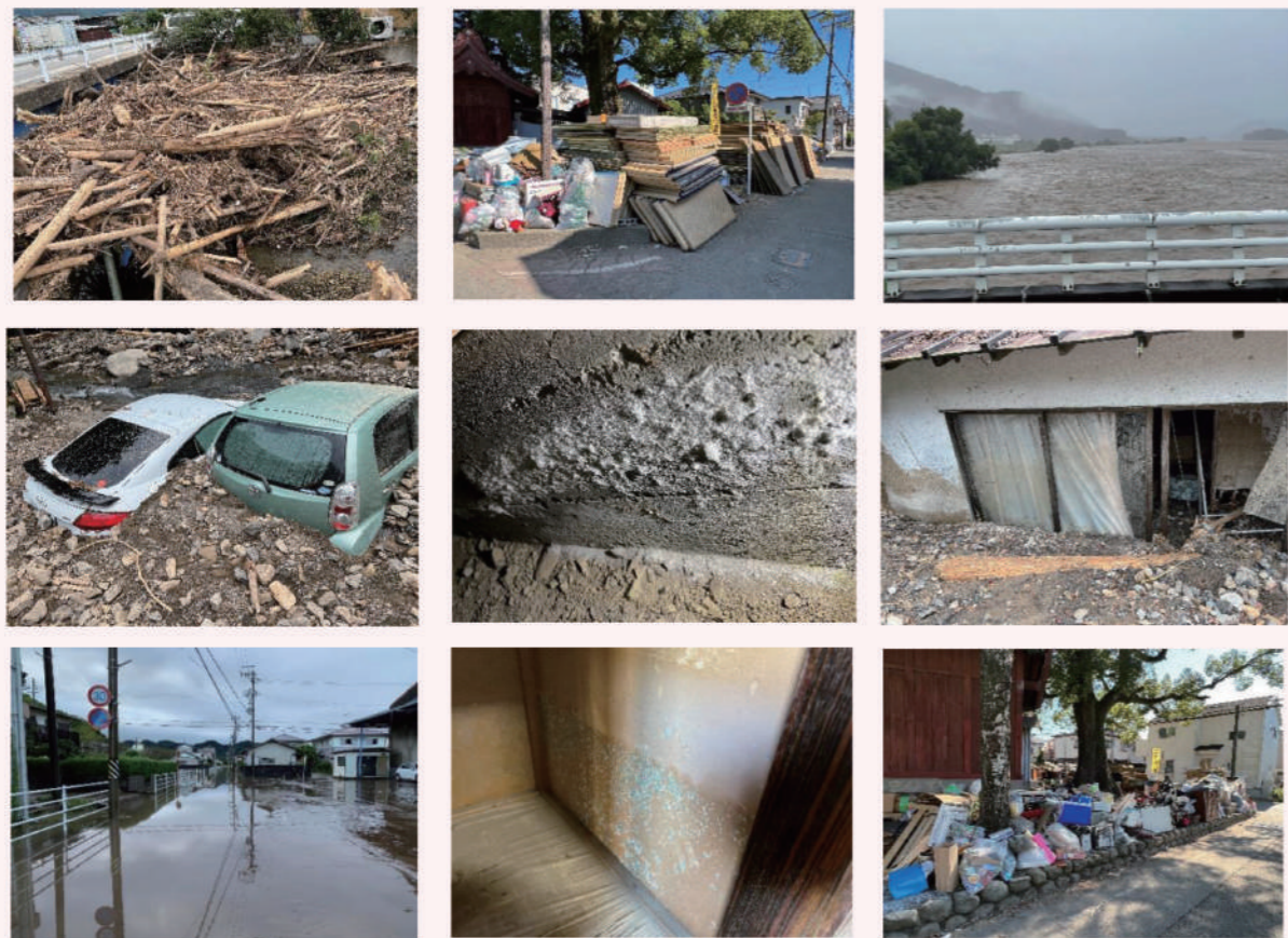
上の写真は9月23日、24日に静岡県内を通過した台風15号による静岡市の被害写真です。このように毎年2~3回ほどは各地で水害・土砂災害が起っています。
